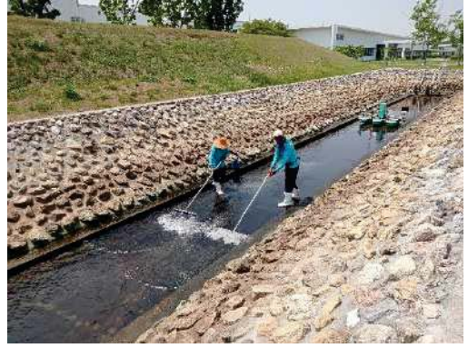
ภาพที่ 2-33 การล้างทำความสะอาด Recycle Pond
