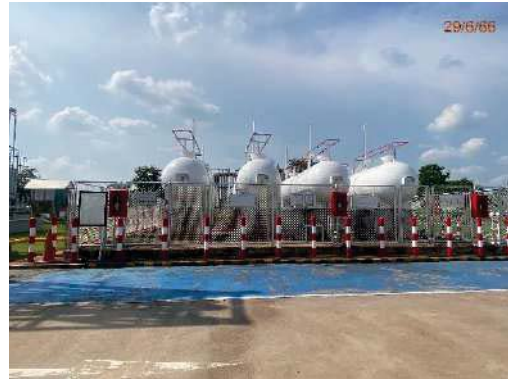
ภาพที่ 2-28 ป้ายเตือนอันตรายและวิธีปฏิบัติด้านความปลอดภัย บริเวณถังเก็บก๊าซ LPG
