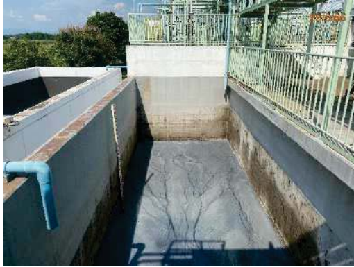
ภาพที่ 2-11 ถังพักน้ำฉุกเฉิน (Emergency Tank)
